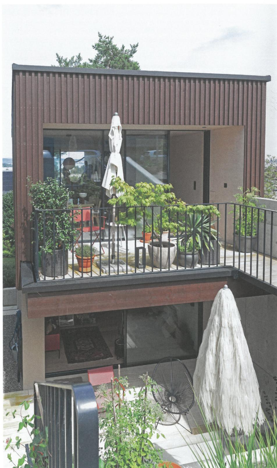
Der Eingang führt über eine Brücke. Der Holzbau wurde vorgefertigt und in einem Stück versetzt.
